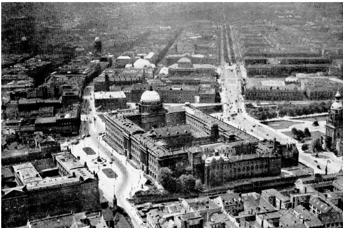
Fig. 2h. El Palacio de los Hohenzollern (Die Stadtschloss), el palacio de los Emperadores de Prusia en el extremo este de Unter den Linden. Demolido por las autoridades de la RDA en 1950.
