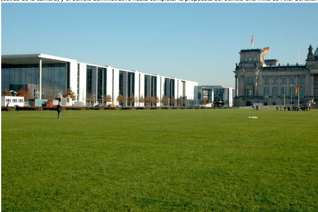
Fig. 38. No hay contacto visual entre el edificio de servicios administrativos y el Reichstag.
